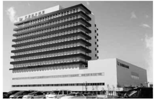
地上12階建ての病院として新築された行徳総合病院
