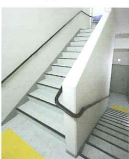
一見、普通の階段に見えるが、実は1段の高さが普通より低く設計されているリハビリ用の階段
